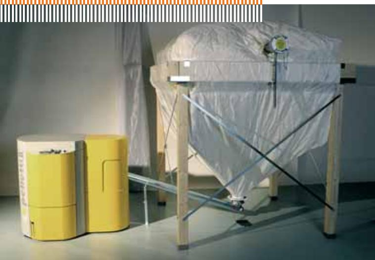
Beispiel für ein Pelletlager mit Gewebesilo und Austragung
